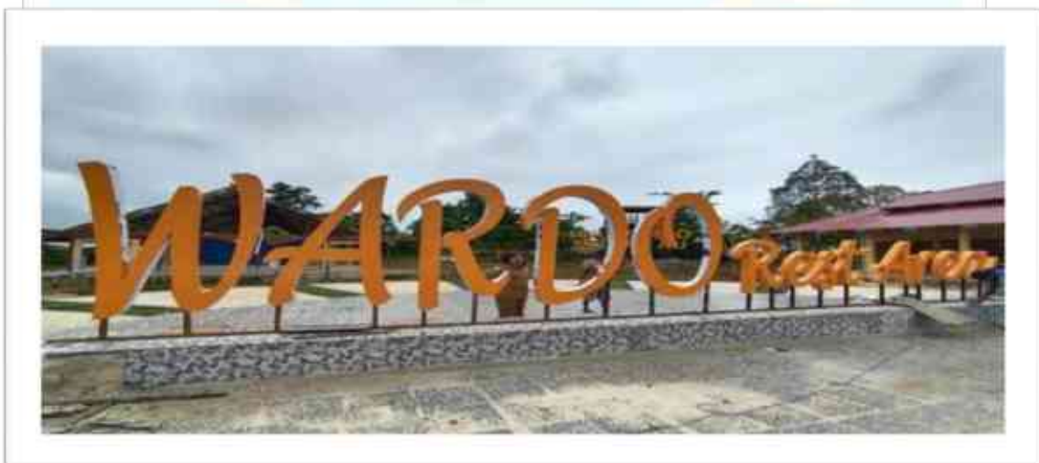
Gambar 3.22 Pembangunan Plaza dan Gazebo Pengunjung Kali Wardo
